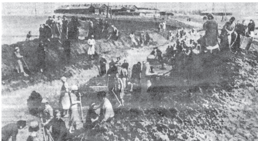
Жители города на строительстве оборонительных сооружений. 1941 г.
